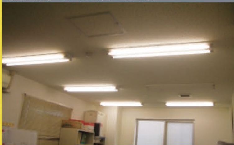
【蛍光灯】のLED化 施工例
